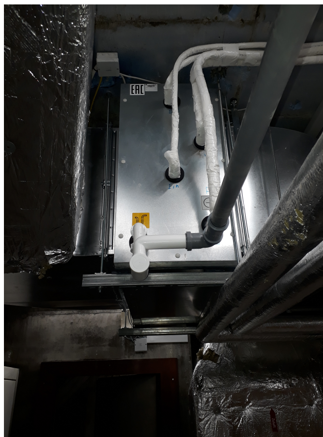
Hier sieht man das neue Register, welches in die bestehende Lüftung eingebaut wurde.
