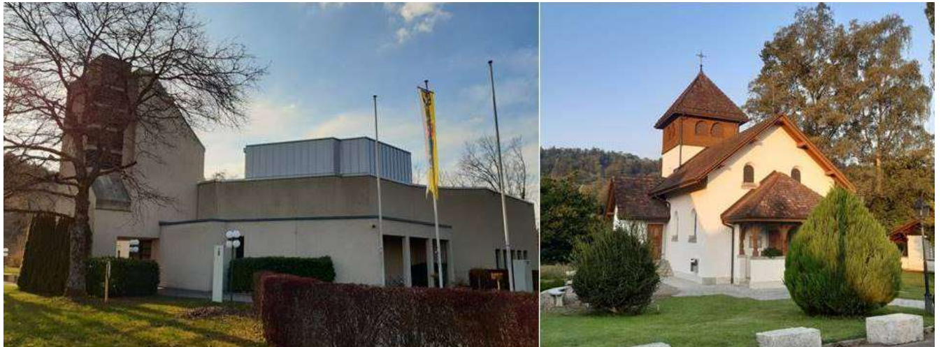
Abbildung 2: Kirchgemeindezentrum und Kapelle
